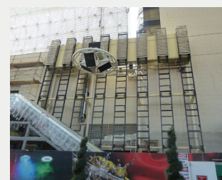
Installation à Vegas, les colonnes d'écrans vidéo sont éloignées l'une de l'autre
