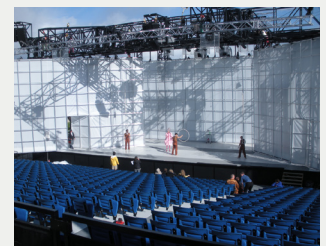
Mur de projection avec grillage d'aluminium
