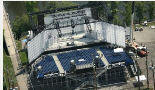
Vue aérienne de l'auditorium
