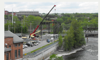
Montage de la scène sur site
