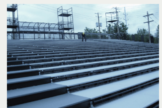
Montage du gradin sur site
