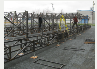
Pré-montage de la scène avant galvanisation
